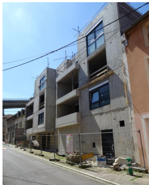
Rue Poincaré à Hayange
