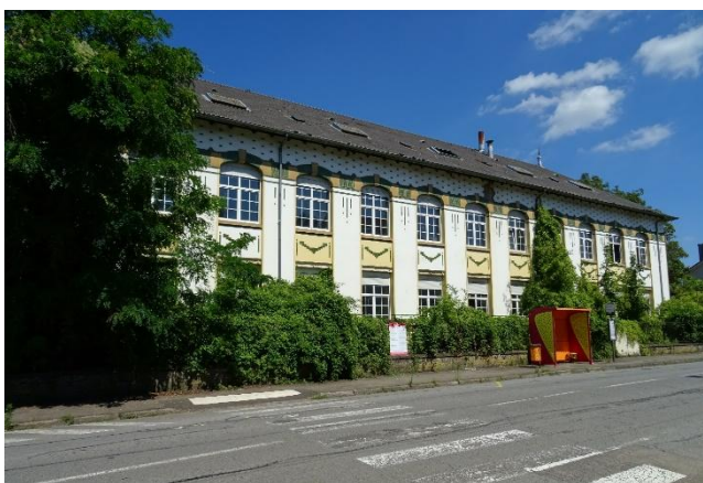
Rénovation d'un ancien immeuble de bureaux pour la création de 26 logements collectifs sociaux Vivest à Serémange-Erzange
