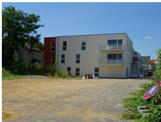
Rue du Grand Chemin à Serémange-Erzange
