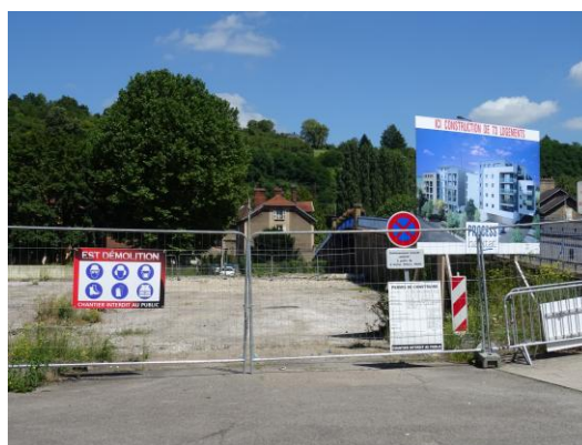
73 logements séniors et sociaux, rue Jean Moulin à Hayange
