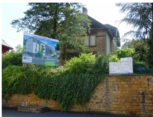
46 logements, rue Foch à Algrange
