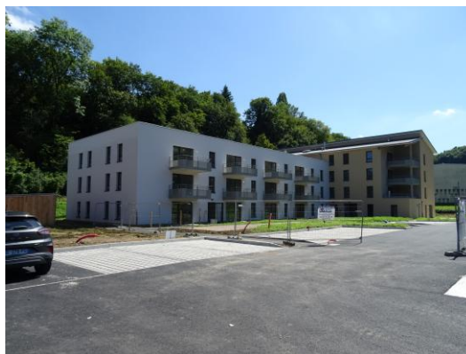
72 logements rue de la Mine à Hayange
