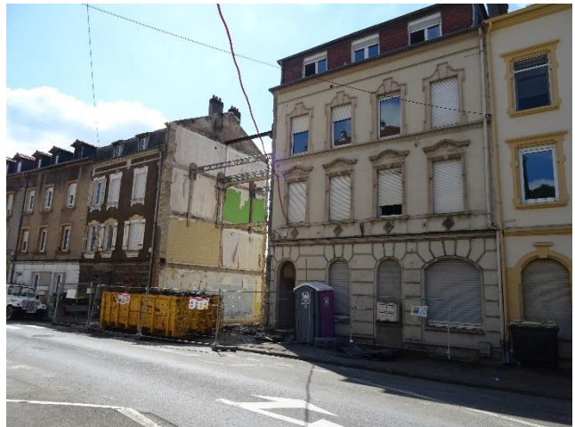
Création de 10 logements Batigère à Nilvange
