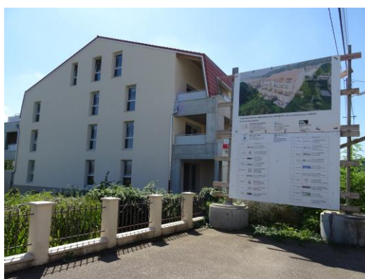
110 logements rue de Ranguieux à Fameck
