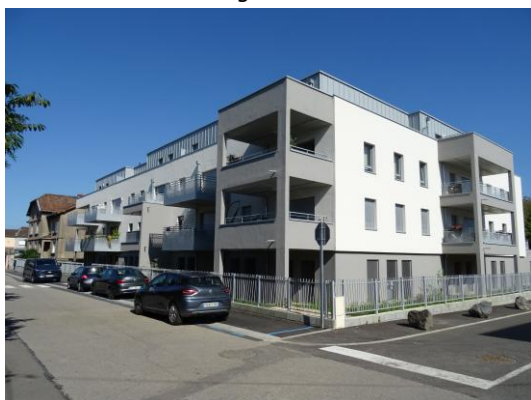
Rue de l'Ancienne Poste à Uckange
