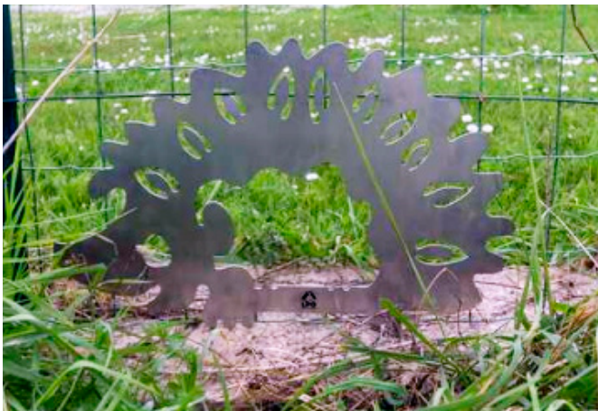
Exemple de passage à petite faune dans une clôture
