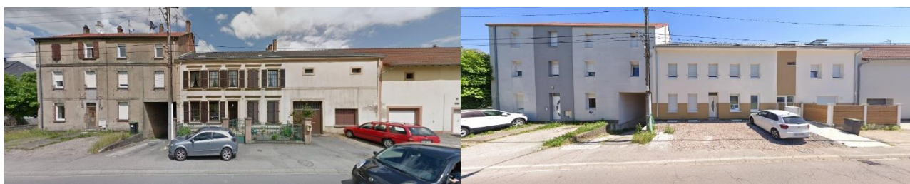
Source : 6 logements collectifs créés sur de l'existant au 32 rue Principale à Betting, situation en 2012 et 2021, Google Street View
