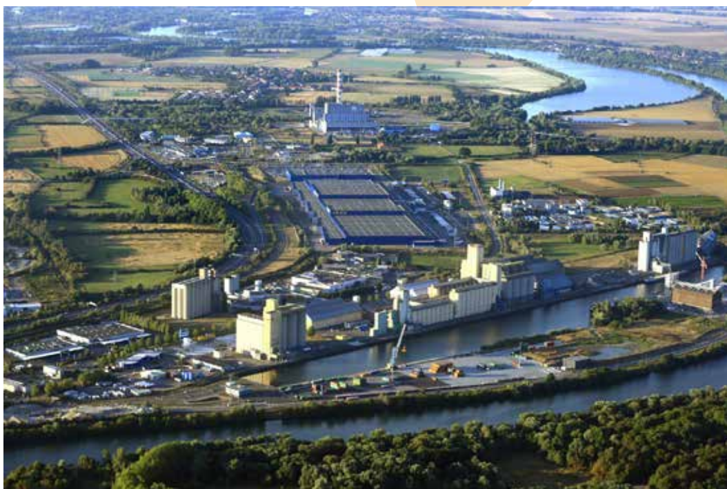
Le nouveau port de Metz et la base logistique d'Ikea dans son prolongement © Républicain Lorrain
