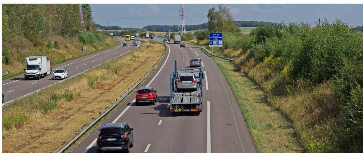
L'AUTOROUTE A4 SUR LE TERRITOIRE INTERCOMMUNAL AU NIVEAU DE LA COMMUNE DE BROUCK
